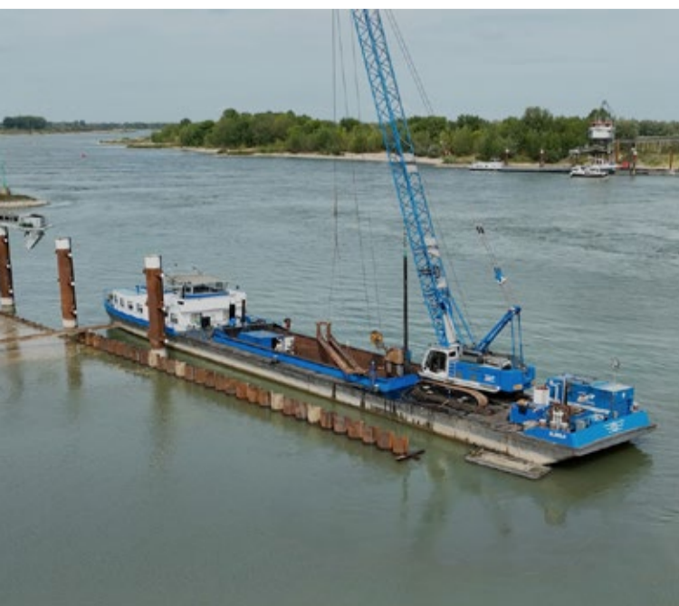
Het plaatsen van de damwand
